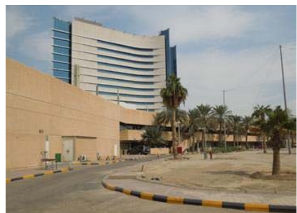
図 1-3 KISR 本部新館とエネルギー・建築研究センター(EBRC)
